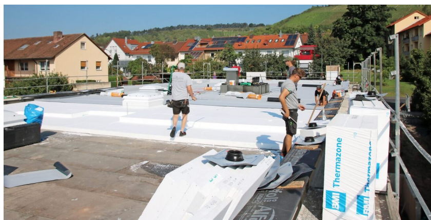
Mitarbeiter der Firma Kleinhenz und Wehner aus Langenleiten dichten aktuell das Flachdach des Verwaltungsgebäudes mit Speisesaal und Küche ab.
