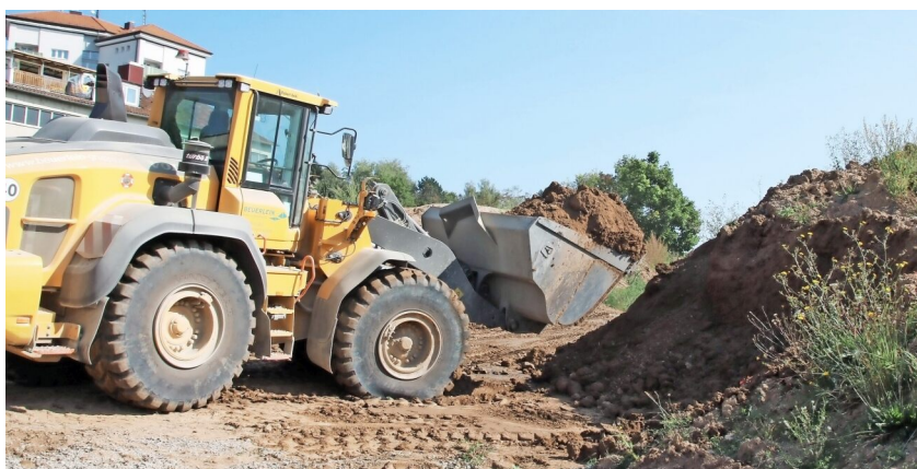
Jede Menge Erde wurde auf dem 9000 Quadratmeter großen Grundstück bewegt, demnächst wird ein Privatweg von der Würzburger zur Berliner Straße gebaut.
