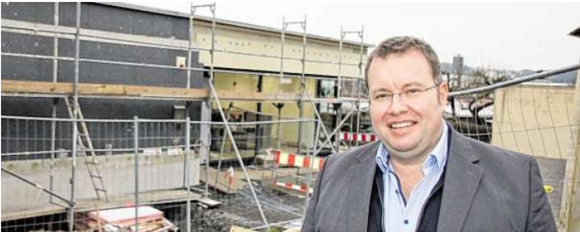
Innen ist alles fertig, außen stehen noch Restarbeiten an: Werkstattleiter Thomas Porkristl steht vor dem Verwaltungsgebäude, hier soll künftig der Haupteingang von der Berliner Straße her entstehen. Vorher müssen Fassade und Parkplatz fertig sein.
